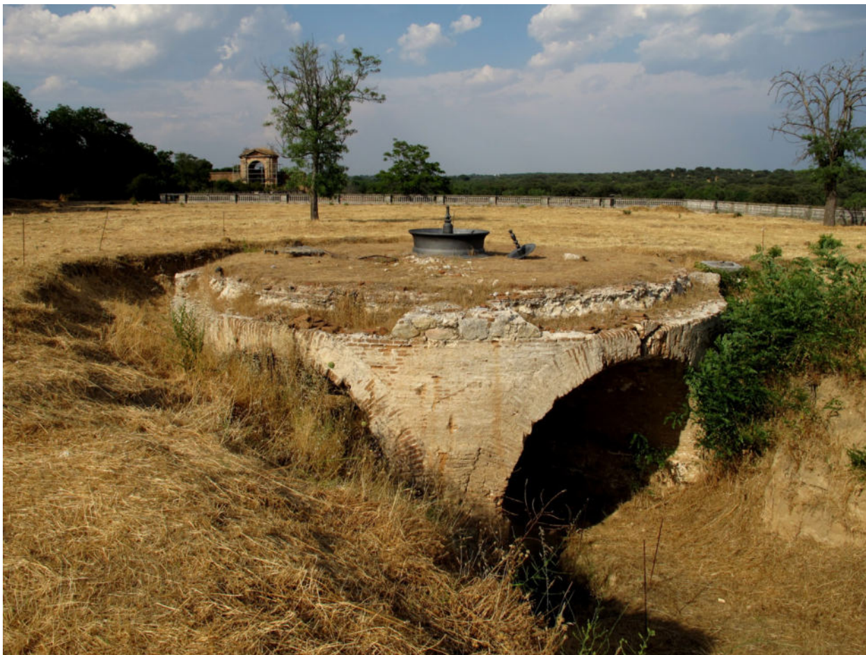
Fig. 96- Cimiento de la Fuente de las Conchas en el palacio de Boadilla del Monte. Fotografía: VPAT.
